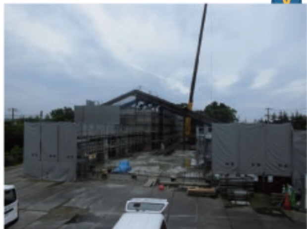
2017年8月1日撮 新図書館建設現場
